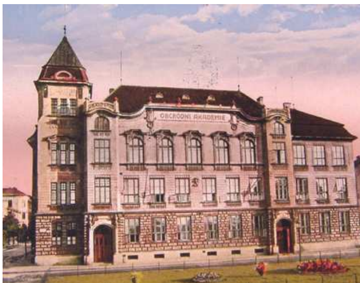
Původní sídlo Obchodní akademie, později budova EKF.
